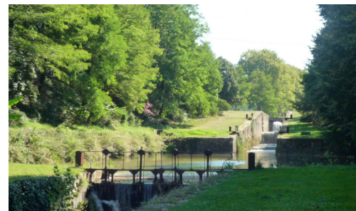
4. Canal de Lalinde et ses écluses
